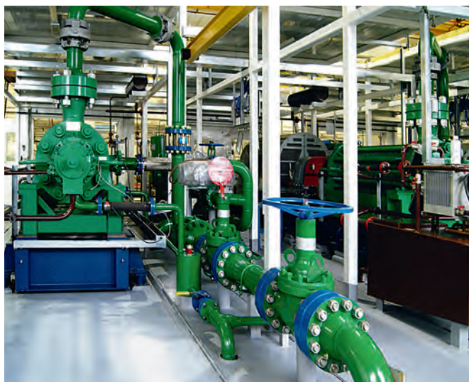
Блочная кустовая насосная станция для ООО РН-Юганскнефтегаз
